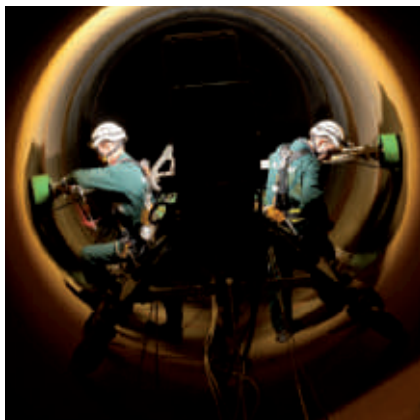
Travaux de maintenance dans un puits blindé de l'aménagement d'Emosson.
