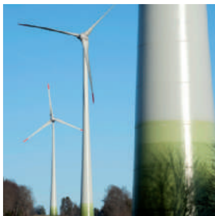
Le parc éolien d'Alpiq « Le Peuchapatte » est en service depuis 2011.
