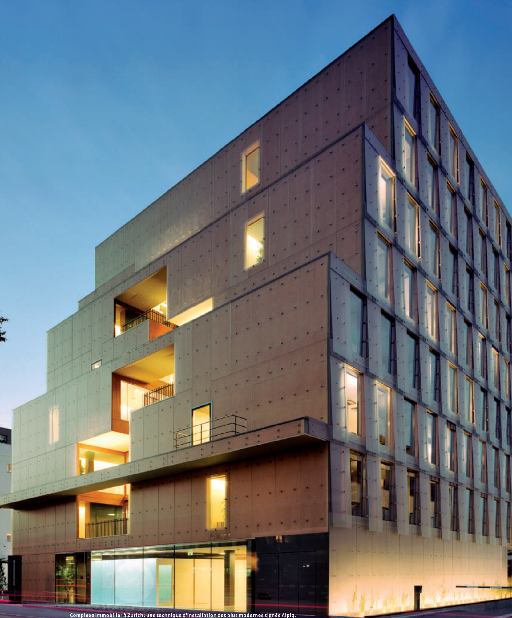
Complexe immobilier à Zurich : une technique d'installation des plus modernes signée Alpiq.
